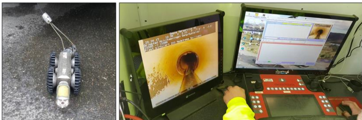
Figur 6. 17: Rørinspeksjon med kamera utført av Søgne Rørservice
