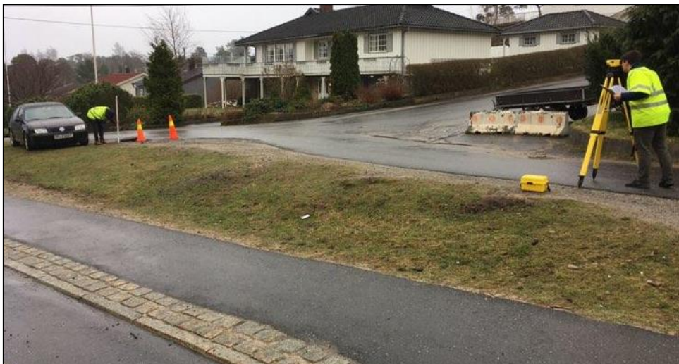
Figur 6. 12: Nivellering av ledningsstrek
